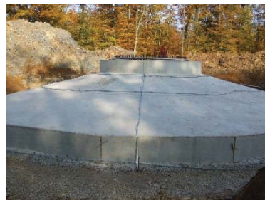
Massif d'éolienne avec ceinture équipotentielle pour MALT
