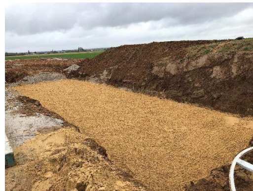
Exemple de fond de fouille pour poste de livraison éolien.
