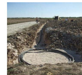
Pose de réseaux HTA
