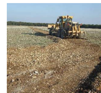
Décapage pour câblage
